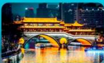
สะพานอันชุน
